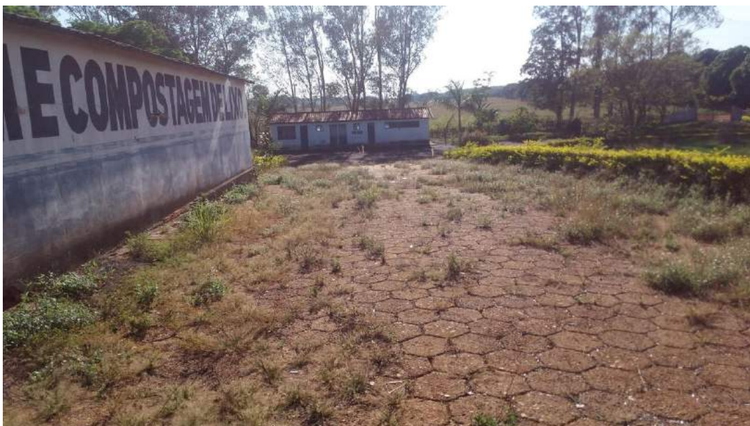
FIGURA 10: Fachada abandonada da UTC.
