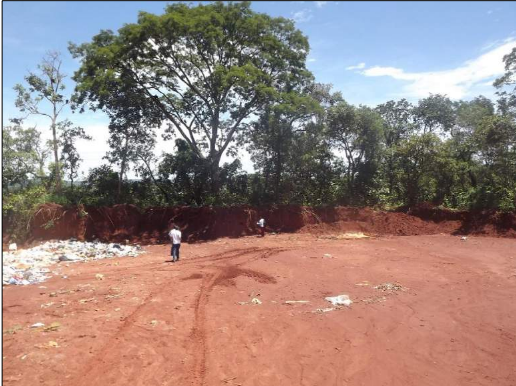
Figura 14 – Trincheira aberta no aterro de Gurinhatã. Março, 2015.
