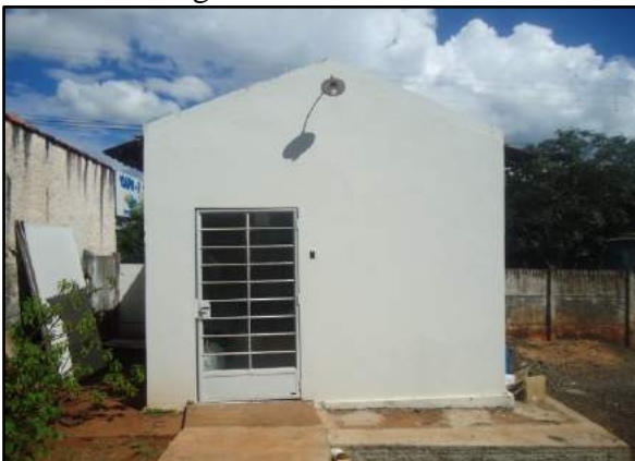
Figura 6: Unidade de transbordo pra resíduos de serviços de saúde no Hospital Santa Casa de Monte Alegre.
