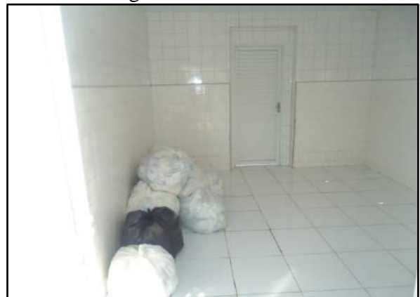
Figura 7: Unidade de transbordo pra resíduos de serviços de saúde no Hospital Santa Casa de Monte Alegre.
