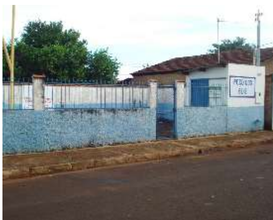
a) Localização do poço e instalações complementares, na rua dos Pereiras, número 650
