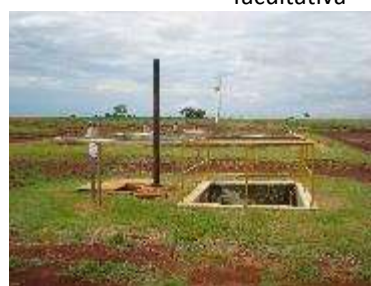
Poço de sucção do líquido percolado
