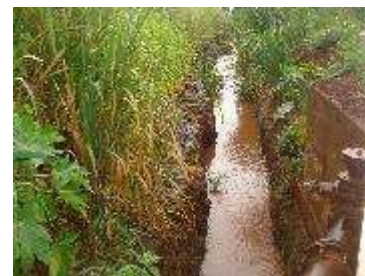
Jusante do bueiro 1
