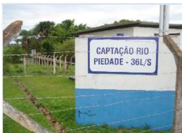
a) Estação elevatória de água bruta do sistema Piedade. Ao fundo, percebe-se o trecho inicial de adução.
