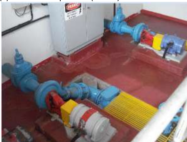
(d) Estação elevatória de transferência entre os reservatórios 2 e 3
