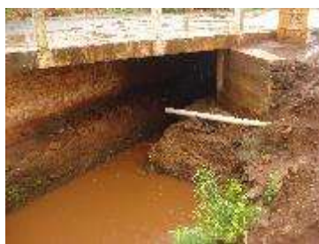
Montante do bueiro 1
