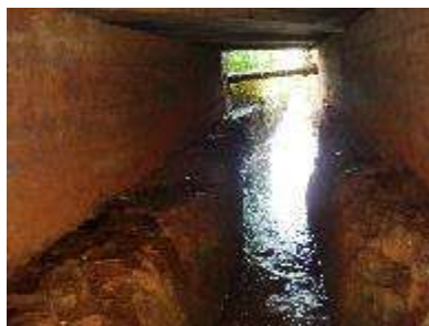
Seção transversal do bueiro 1
