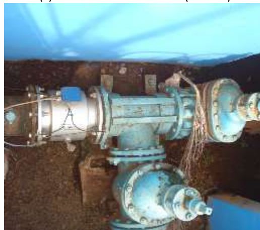
(e) Macromedidor de vazão eletromagnético
