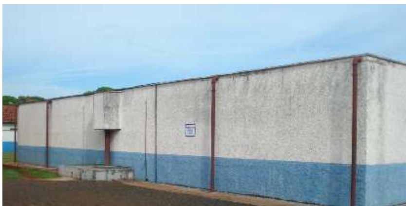
(a) Reservatório apoiado 1, com capacidade de 1128 m 3
