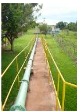
c) Início do trecho de recalque e adutora de água bruta d) Trecho final da adutora de água bruta
