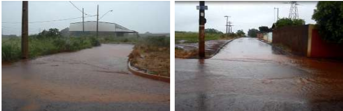
Figura 110: Imagens de sarjetões existentes na área urbana de Centralina
