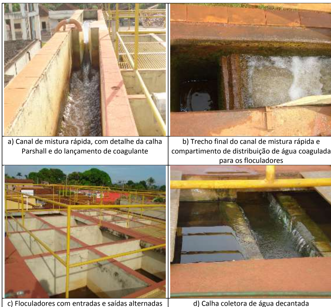
Figura 86: Canal de mistura rápida, floculadores, fev. /2015
