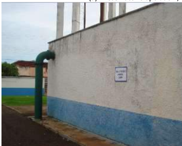
(b) Reservatório apoiado 2 (250 m 3 )
