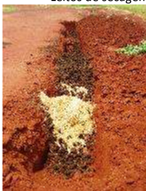
Vala rasa para disposição do lodo desidratado
