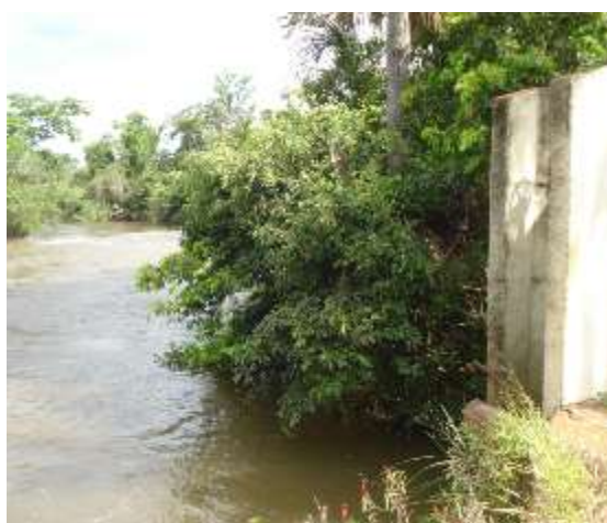
a) Rio Piedade, com destaque para a estrutura de tomada de água em concreto armado
