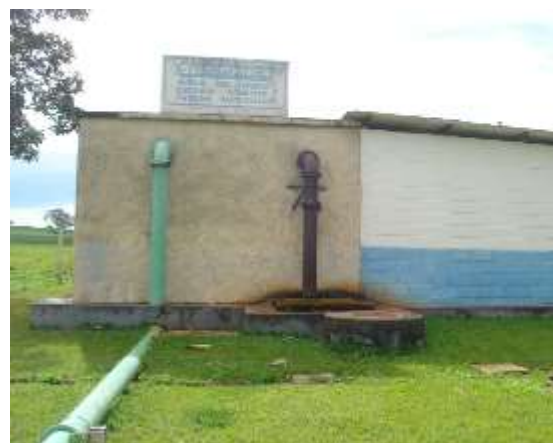
c) Início do trecho de recalque e adutora de água bruta d) Trecho final da adutora de água bruta
