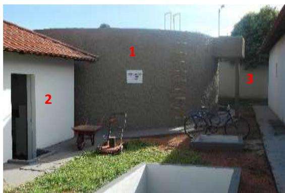
a) (1) RAP-1, (2) elevatória de água para o REL-2, (3) chegada de água dos poços
