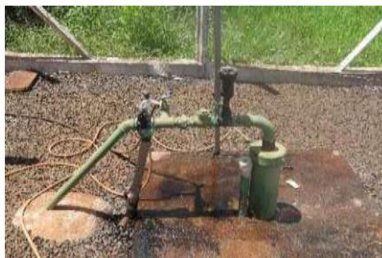
b) Vista dos componentes da tubulação de recalque junto ao poço
