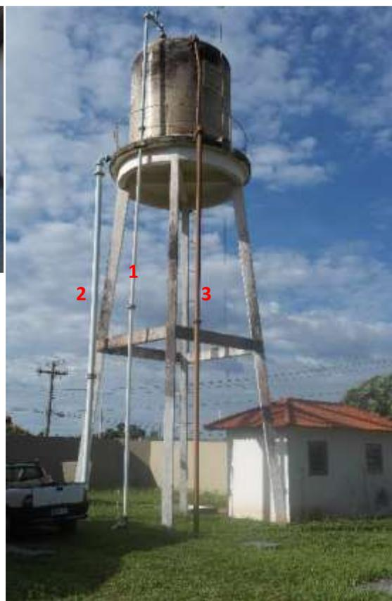
c) REL-2 com destaque para entrada (1) e saída (2) de água e extravasor (3)
