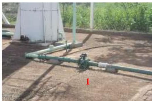
a) REL e chegada de água do poço com detalhe para o macromedidor (1)
