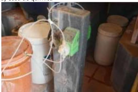
c) Reservatório de solução de ácido fluossilícico e bombas dosadoras
