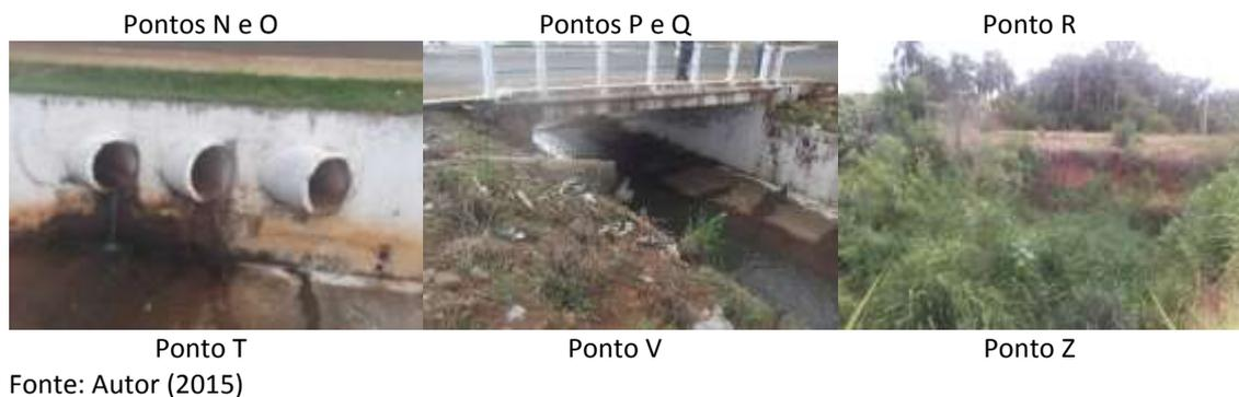
Nas vias paralelas aos trechos canalizados dos córregos Maria Elias e Monte Alegre existem bocas de lobo nas esquinas e no meio das quadras, cujo objetivo é receber a água pluvial que escoar superficialmente sobre estas ruas e transportá-la por meio de tubulação de ligação até o canal. As tubulações de ligação possuem diâmetros de 0,3 e 0,4 m e material de concreto. A Tabela 11 traz os pontos georreferenciados de lançamento final das galerias no sistema de macrodrenagem, em coordenadas UTM.
