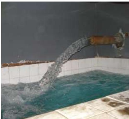
Poço 20 (Horta Comunitária): injeção em reservatório adjacente. Ilustração da descarga de água, proveniente do poço, no reservatório
