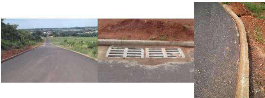
A Norma Técnica NBR ABNT 9648/1986, que trata do estudo de concepção de sistemas de esgoto sanitário, define o sistema de esgoto sanitário como separador absoluto. Ou seja, os sistemas de esgotamento sanitário e de drenagem de água pluviais são independentes.
