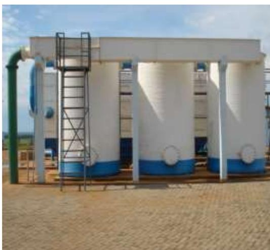
a) Detalhe da entrada de água bruta, do canal de mistura rápida e dos três flocoadores
