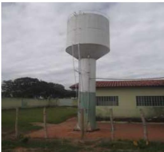
A) Reservatório 1: capacidade de 10 m<sup>3</sup> e altura de 8 m
