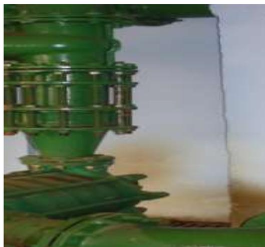
(b) Detalhes do tubo de sucção e do trecho inicial de recalque
