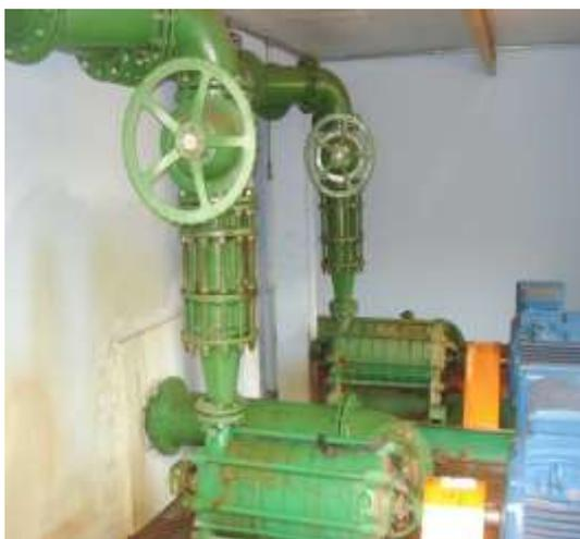
(a) Instalação dos conjuntos moto-bomba de 7 estágios e potência nominal de 175 CV
