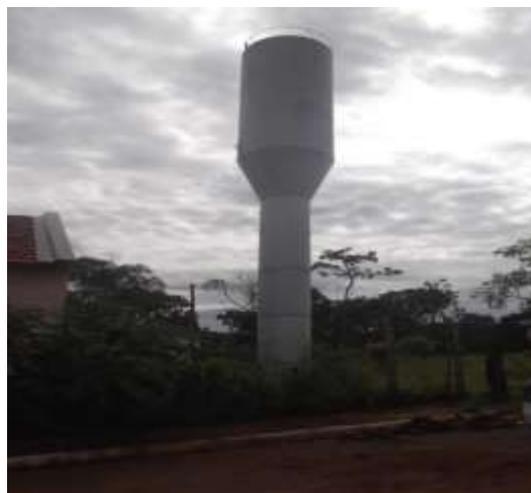
B) Reservatório 2: capacidade de 6,5 m<sup>3</sup> e altura de 9 m
