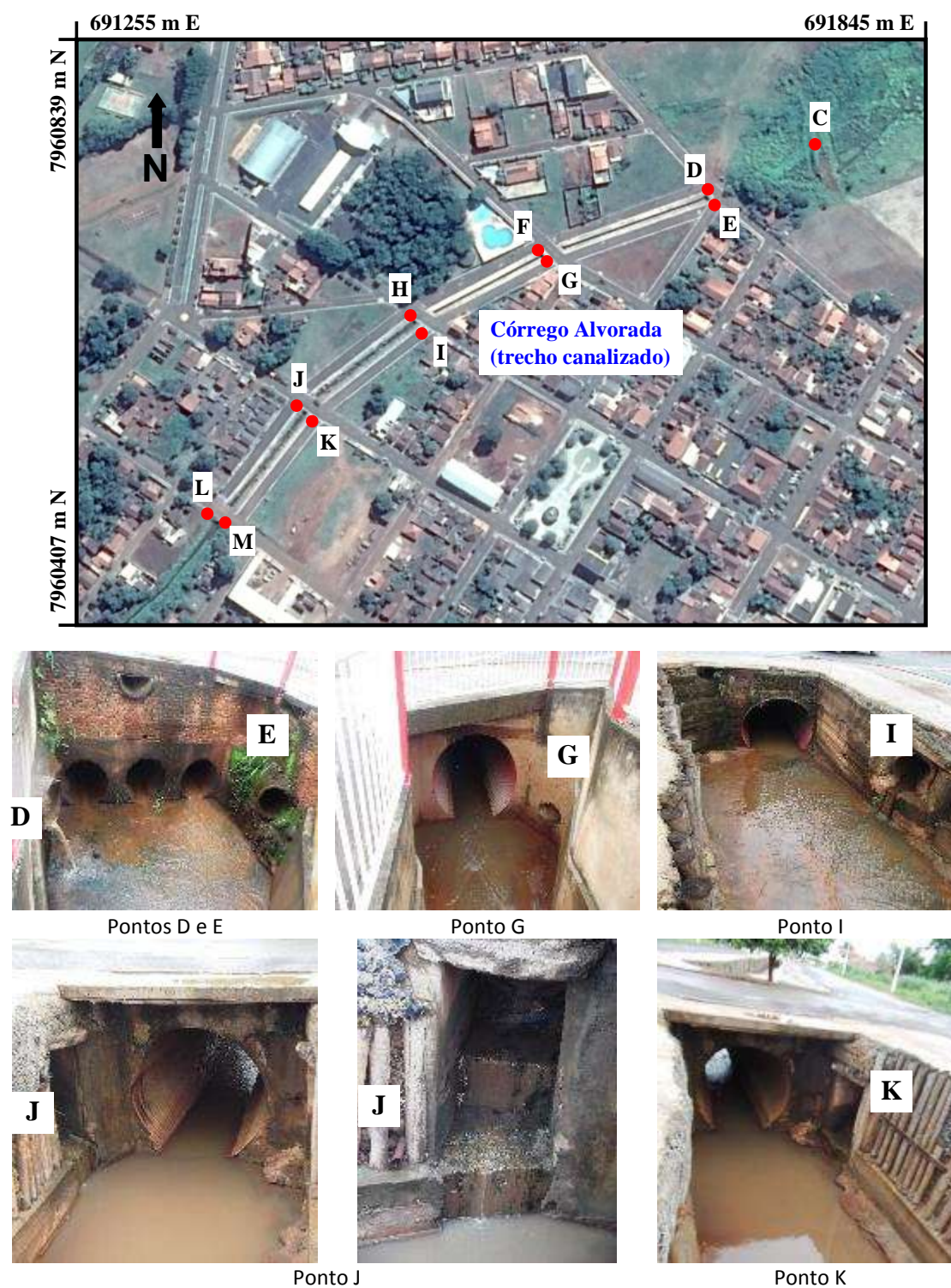
Figura 137: Pontos finais das galerias de águas pluviais no córrego Alvorada
