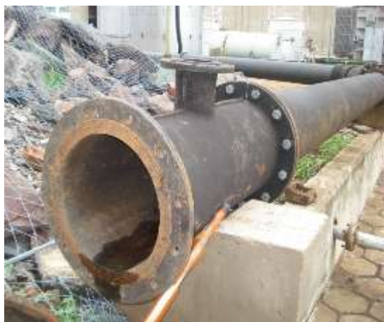
(a) Trecho inicial da adutora em ferro fundido dúctil e diâmetro de 300 mm. Nota-se que resta o acoplamento com a tomada de água.
