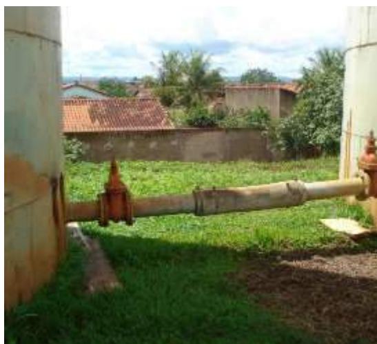
(c) Esquema de interligação entre os dois reservatórios
