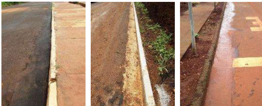
Figura 132: Imagens de sarjetas existentes na área urbana
