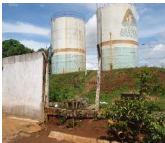
(b) Detalhe da tubulação extravasora de água, com descarga diretamente na sarjeta.
