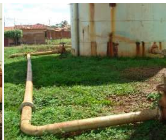
(d) Condutos de saída para a rede de distribuição (tubos de ferro fundido dúctil e PVC com diâmetros de 150 mm)
