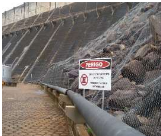
(b) Trecho inicial da adutora, com tubos de ferro fundido dúctil adjacentes ao talude de enrocamento
