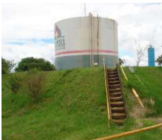
(a) Reservatório da ETA com capacidade de 600 m 3
