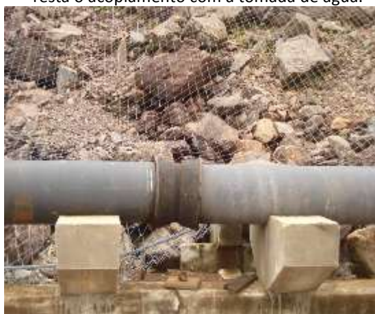
(c) Junção entre tubos de ferro fundido dúctil e do apoio dos dutos sobre pilaretes de concreto.
