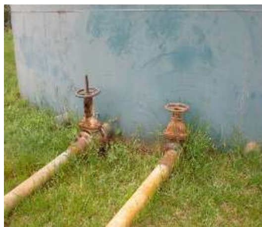
(b) Condutos de saída para a rede de distribuição (PVC com diâmetro de 150 mm)
