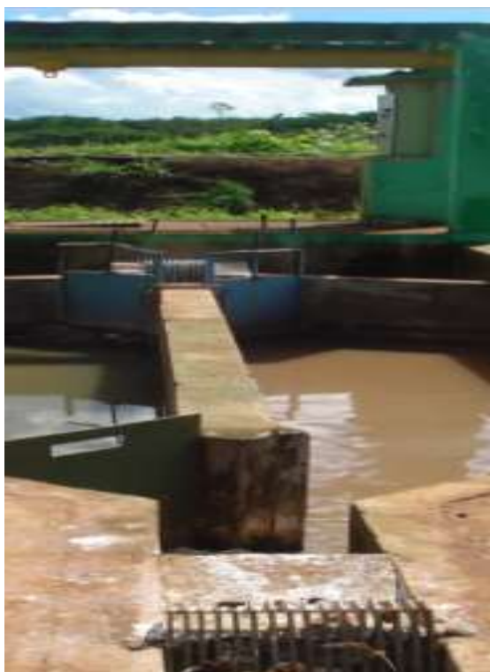
(a) Detalhe da etapa preliminar de tratamento, com gradeamento e desarenador
