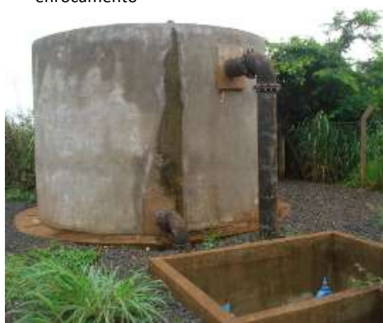
(d) Reservatório de transição com diâmetro de 4,3 m e volume de 50 m 3 .
