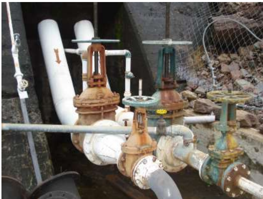
Figura 99: Estrutura de tomada de água do sistema Furnas-Araporã (Dez 2014)
