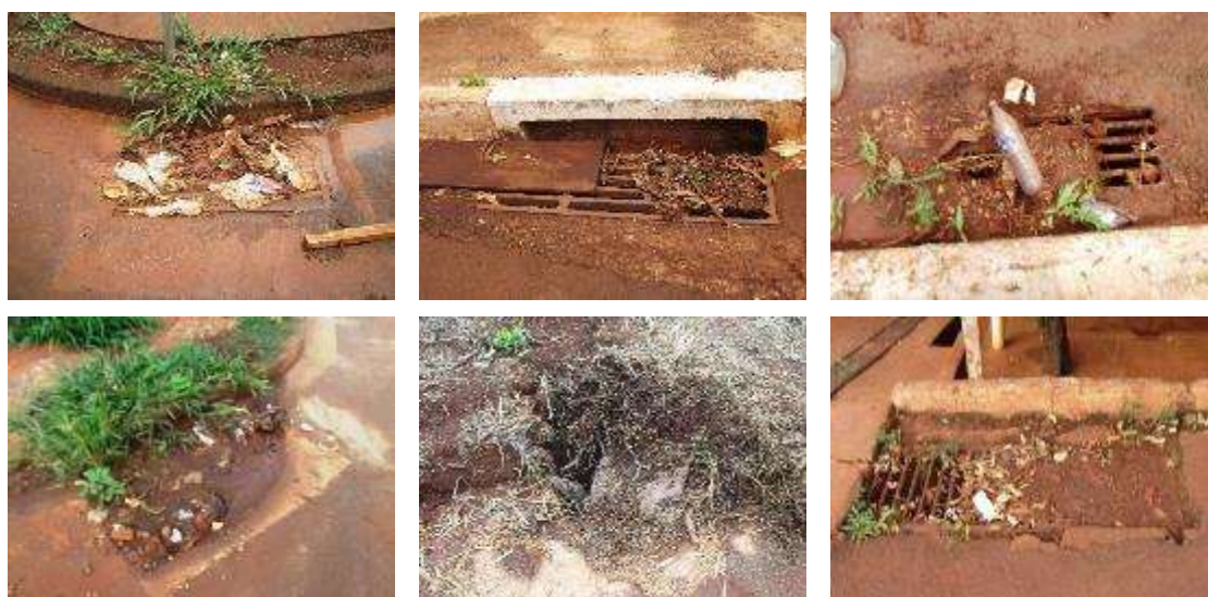
Figura 134: Problemas de entupimento de bocas de lobo
