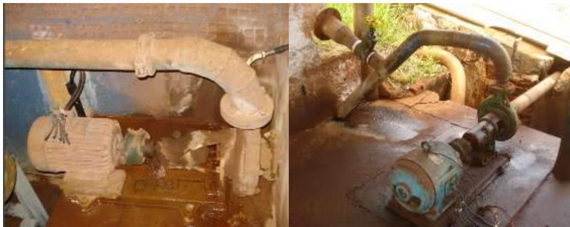
(g) Bomba centrífuga da estação elevatória 1
