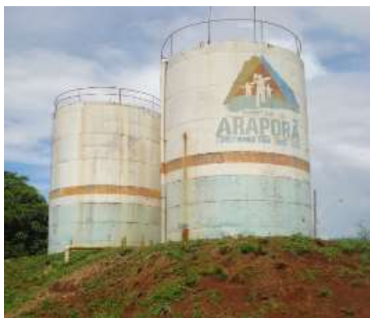
(a) Reservatórios do bairro Primavera, com capacidade individual de 250 m 3 . O tanque da direita é alimentado pela adutora de água tratada que parte da ETA.
