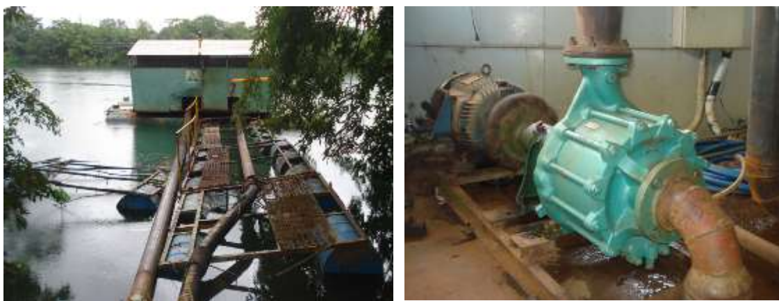
(a) Captação flutuante com destaque para a casa de máquinas e a passarela de acesso (b) Conjunto moto-bomba
