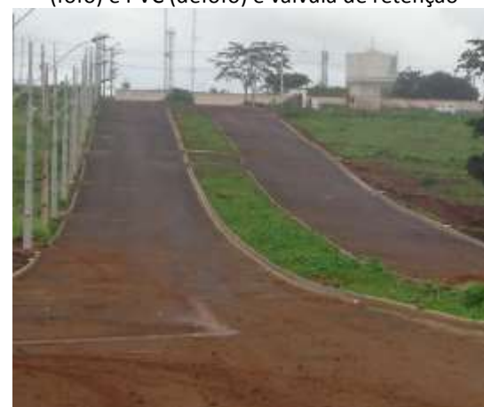
(d) Avenida 26; verifica-se o reservatório de distribuição localizado na ETA
