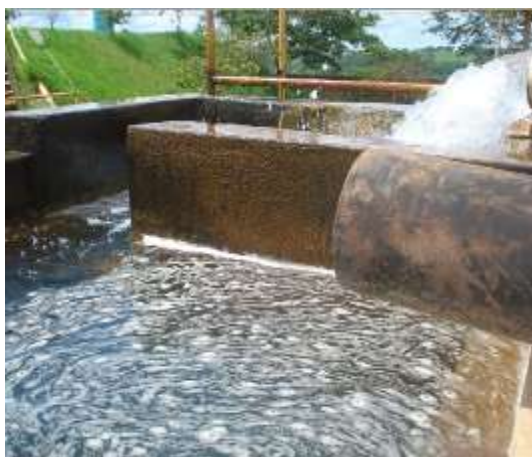
(a) Entrada de água bruta, no tanque de mistura rápida e da entrada nos floculadores
