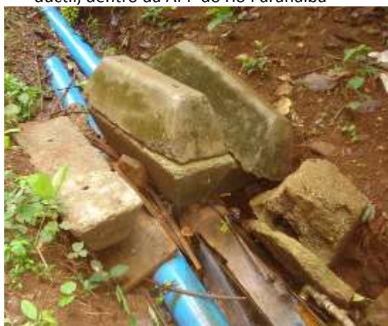
(c) Detalhe de vazamento na junção entre tubos de ferro fundido dúctil e PVC
