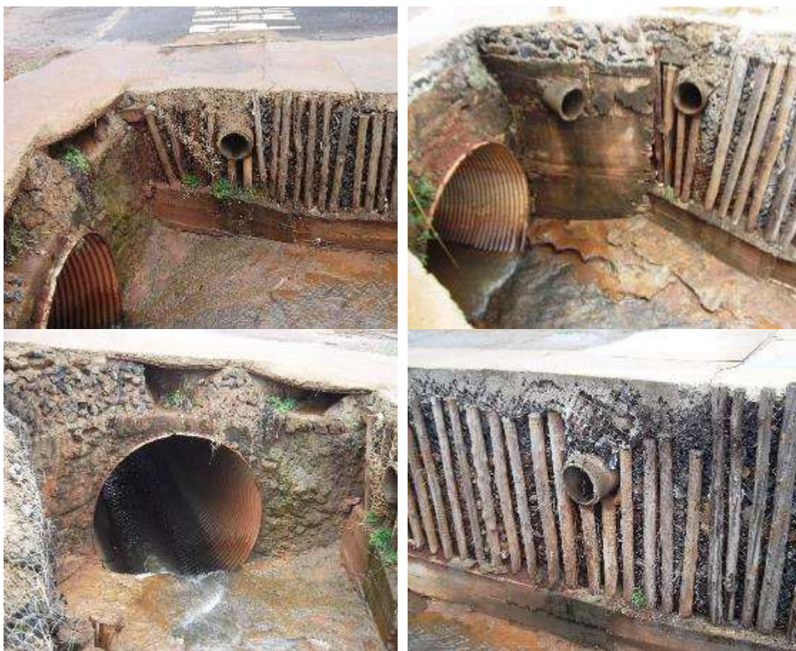
Figura 138: Tubos de ligação no trecho artificial ou canalizado do córrego Alvorada
