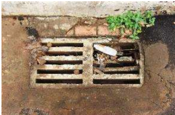
Figura 135: Deformidades no traçado do gradeamento
