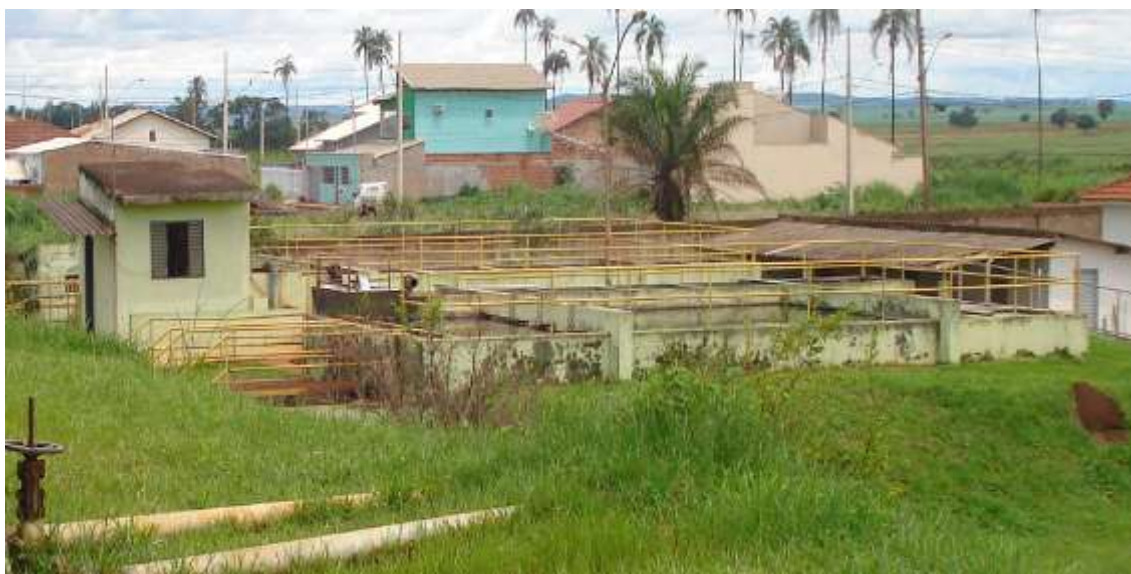
Figura 109: Vista panorâmica da ETA (Dez/2014)
