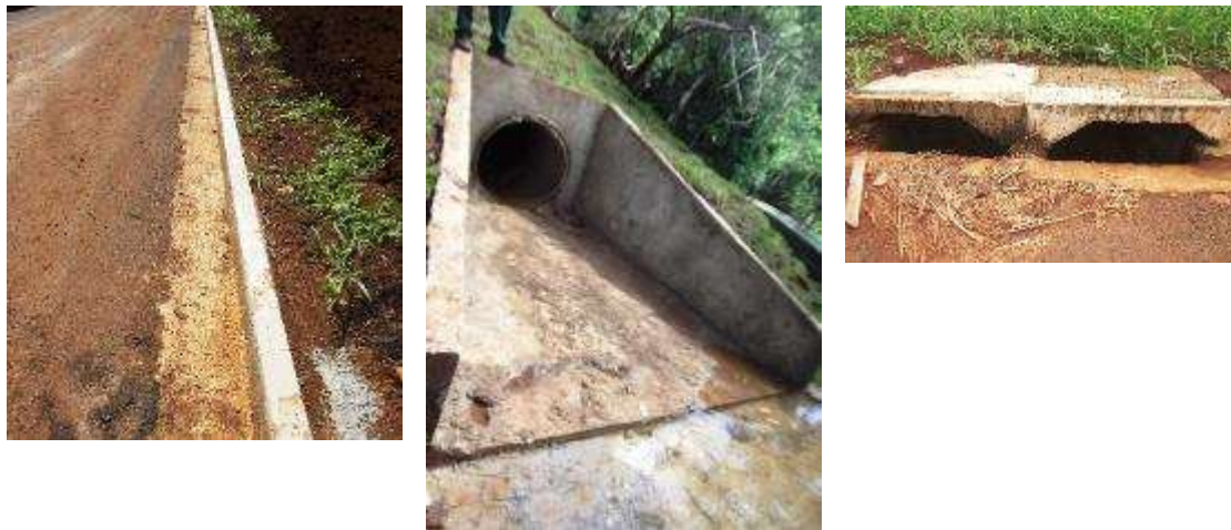
Figura 142: Microdrenagem no novo bairro Jardim Madri
