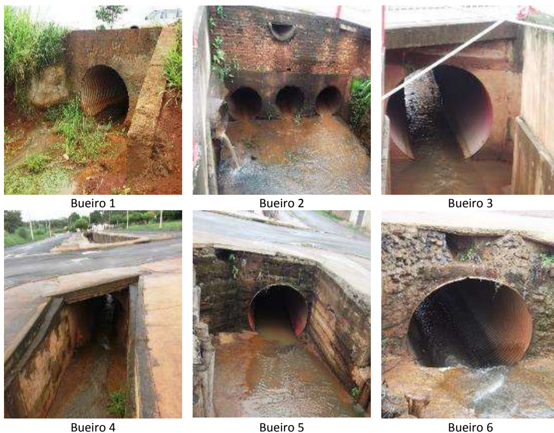
Figura 141: Bueiros existentes nas travessias dos arruamentos pelo córrego Alvorada
