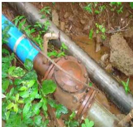
(b) Transição entre dutos de ferro fundido dúctil (fofo) e PVC (defofo) e válvula de retenção
