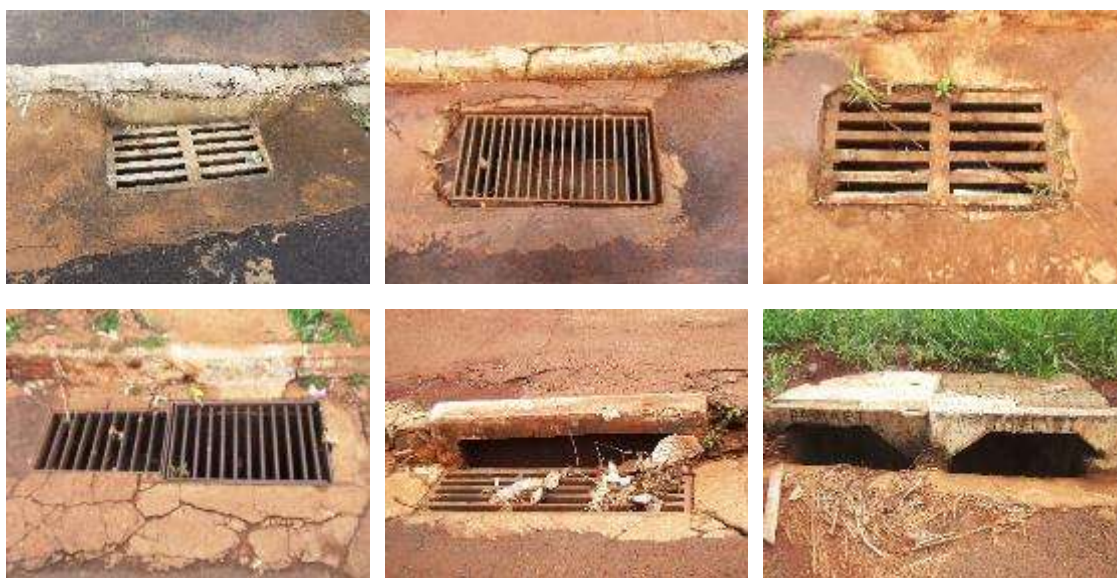
Figura 133: Bocas de lobo existentes na área urbana
