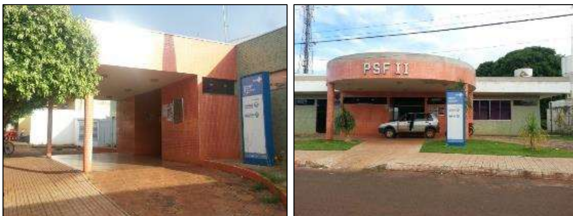
Figura 145: Gerador de resíduos de serviços de saúde público: UBSF
