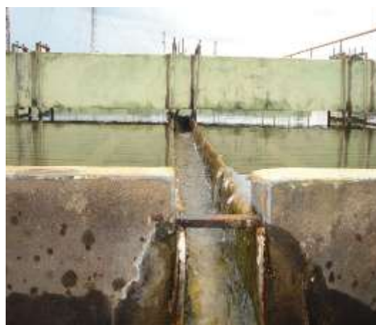
(d) Calha coletora de água decantada
