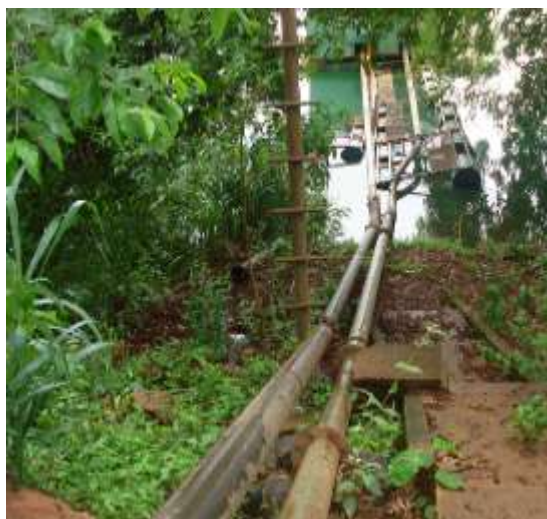
(a) Trecho inicial da adutora em ferro fundido dúctil, dentro da APP do rio Paranaíba
