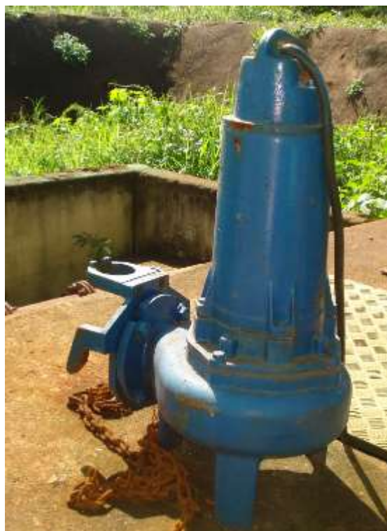
(b) Bomba submersível utilizada para recalcar o esgoto até o reator UASB
