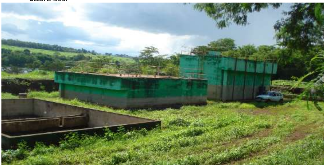
(c) Da direita para a esquerda: reator UASB, filtro anaeróbio e leitos de secagem de lodo
