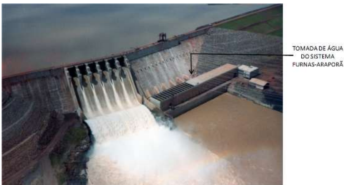
Figura 98: Barragem da UHE de Itumbiara e posição relativa da captação de água
