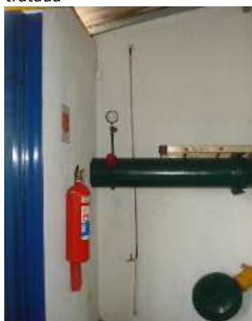
c) Detalhe de manômetro analógico no início do trecho de recalque e de um piezômetro que indica, visualmente, o nível de água no tanque de contato
