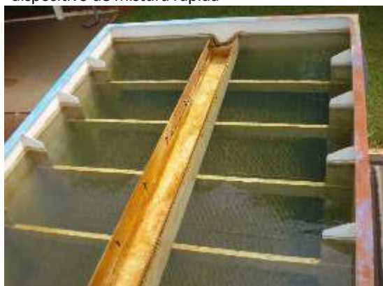
c) Decantador de alta taxa e calha coletora central
