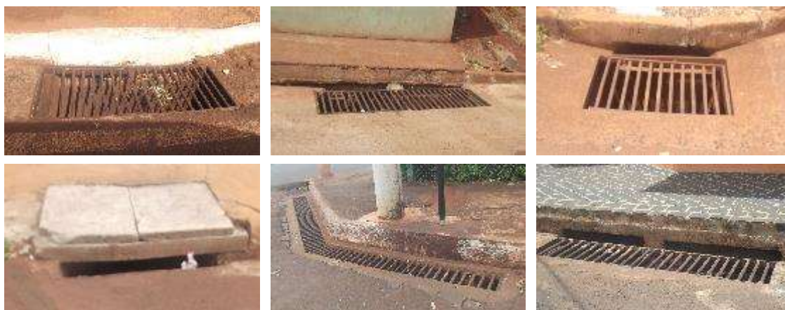
Figura 108: Bocas de lobo existentes na área urbana de Canápolis
