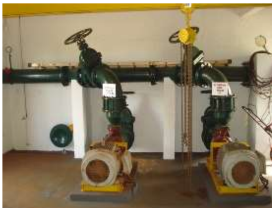
a) Sistemas moto-bomba da estação elevatória de água tratada
