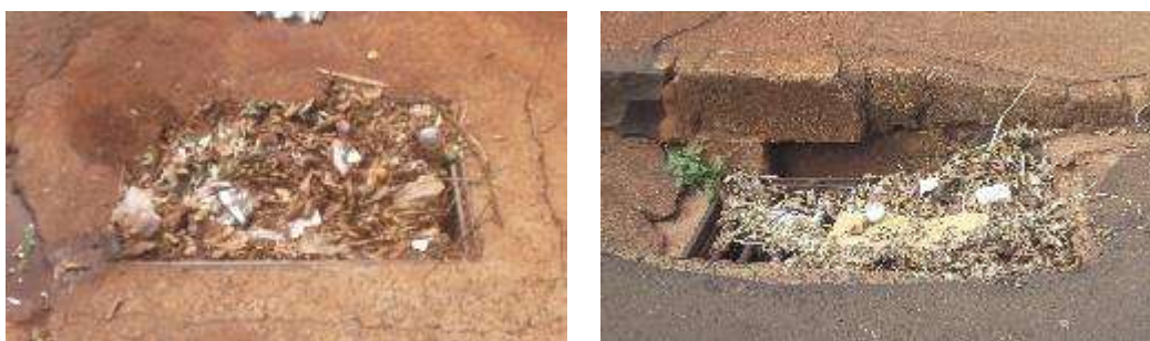
Figura 109: Problemas de entupimento de bocas de lobo
