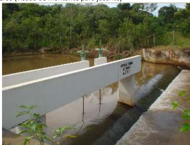
b) Barragem de nível e passarela de acesso sobre o canal de derivação submerso (visada de jusante para montante)
