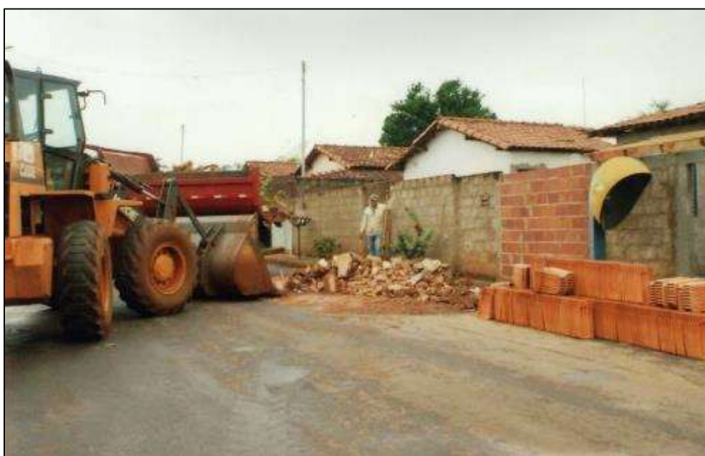
Figura 124: Trator pá carregadeira coletando os resíduos de construção civil
