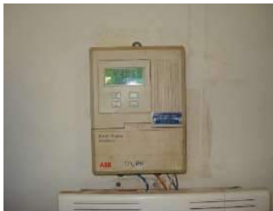
b) Detalhes do leitor digital que registra a vazão instantânea bombeada em litros por segundo
