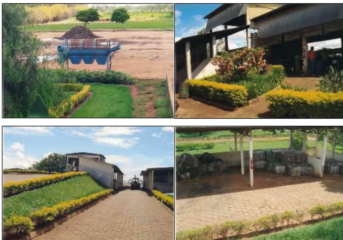
Figura 129: Usina de triagem e compostagem em Canápolis
