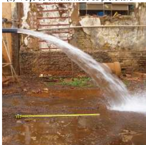
(d) Teste de vazão com jato de água proveniente do poço do almoxarifado da prefeitura
