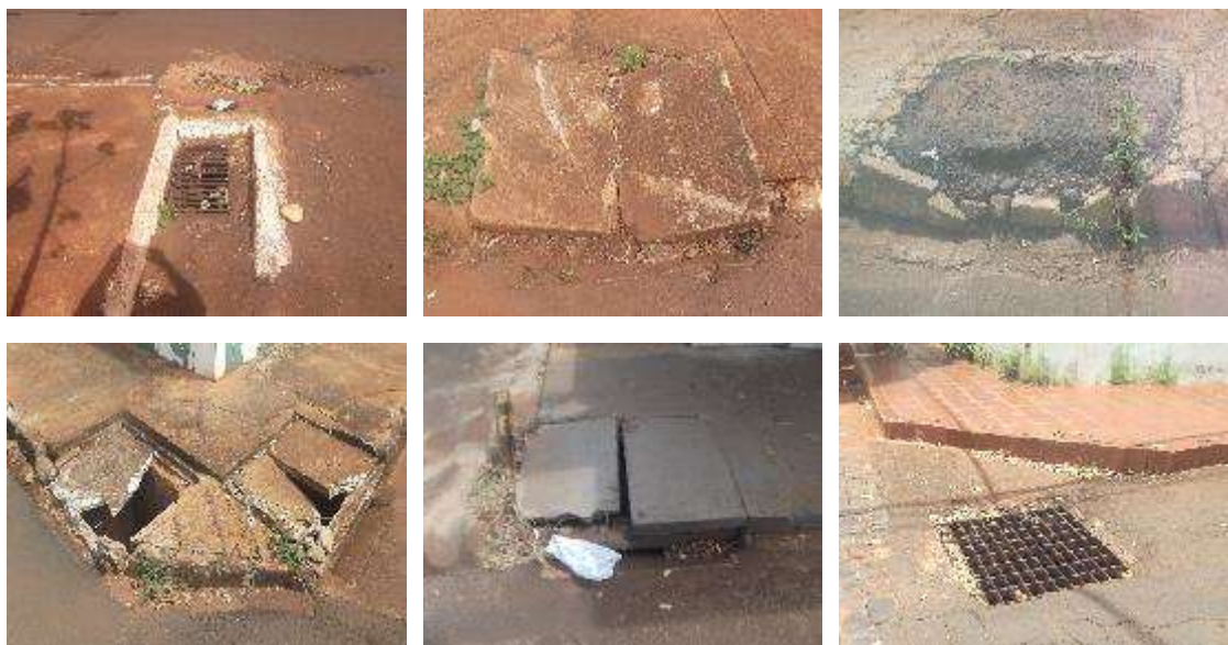
Figura 110: Problemas estruturais e de posicionamento em diversas bocas de lobo
