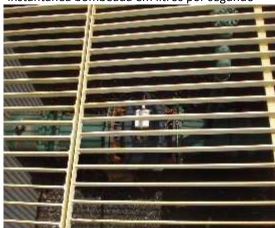
d) Macromedidor eletromagnético que quantifica a vazão aduzida de água tratada
