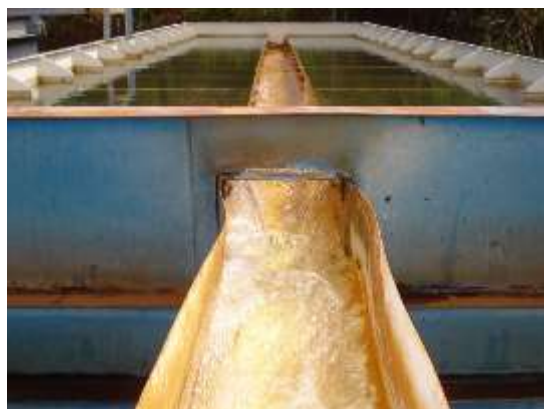
d) Calha coletora de água decantada
