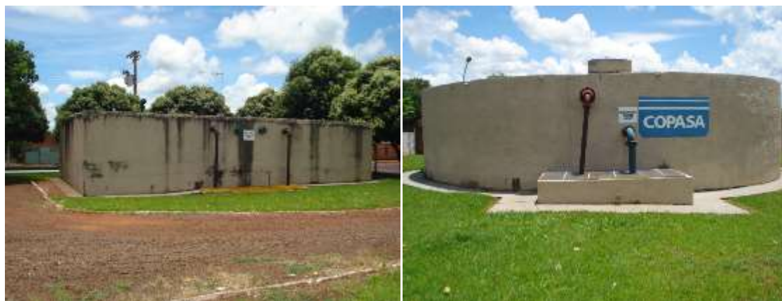
a) Reservatório apoiado R1 (volume de 300 m 3 )
