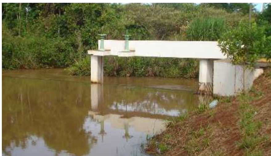
a) Barragem de nível e passarela de acesso sobre o canal de derivação submerso (visada de montante para jusante)
