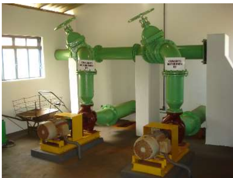
Figura 88: Instalações da estação elevatória de água bruta da cidade de Canápolis, Jan./2015
