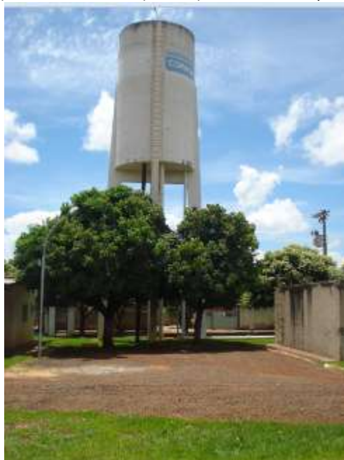
(c) Reservatório elevado R3 (volume de 100 m 3 e 16 m de altura)
