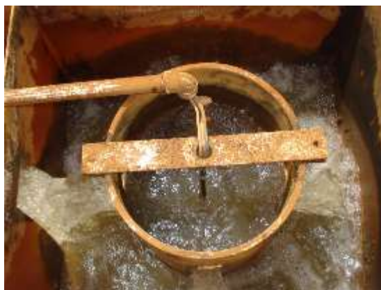
a) Extremidade final da adutora de água bruta e dispositivo de mistura rápida
