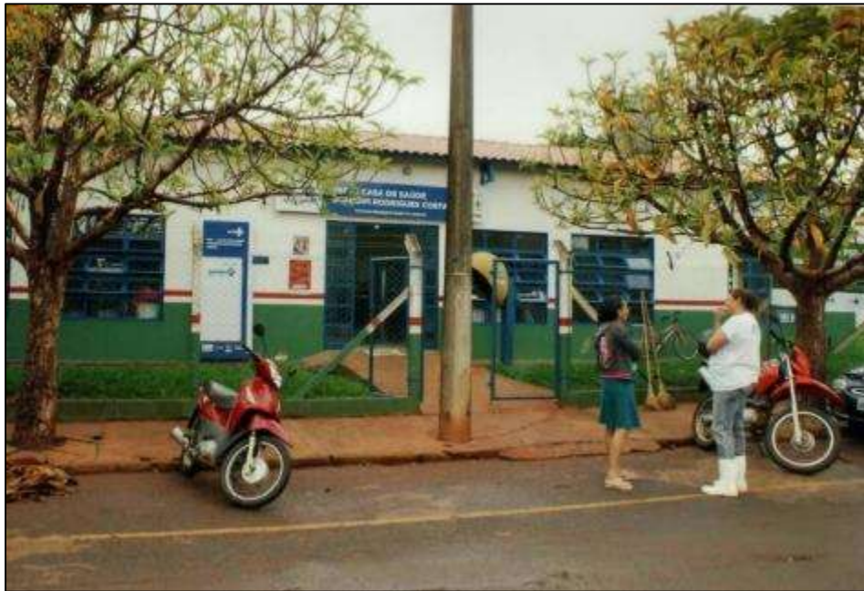
Figura 117: UBSF Casa de Saúde Joaquim Rodrigues Costa em Canápolis
