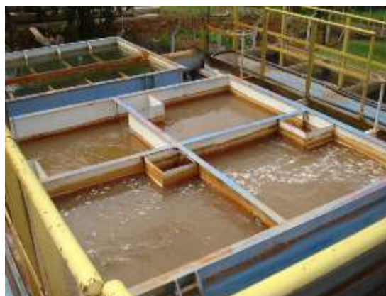
b) Floculadores com entradas e saídas alternadas
