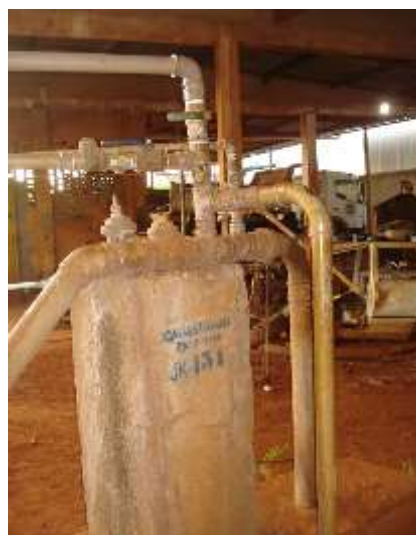
(b) Poço do almoxarifado da prefeitura
