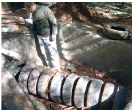
Foto 4 – Câmara de fermentação construída com pneus
