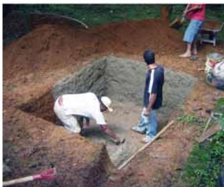
Foto 1 – Vala aberta e chapisco inicial do fundo e paredes do tanque
