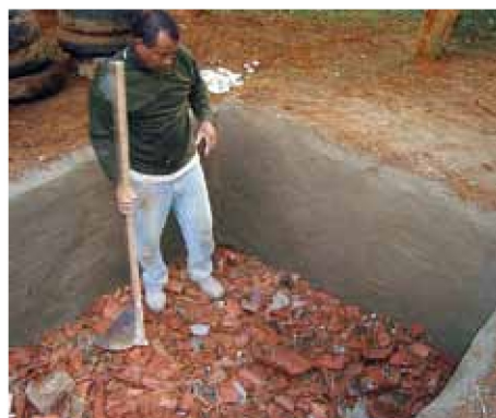
Foto 3 – Camada de entulho no fundo do sistema
