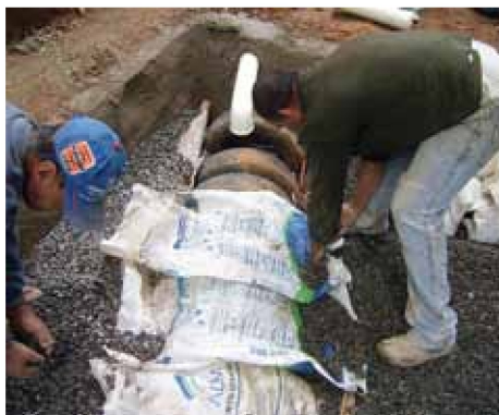
Foto 7 – Vedação superior da câmara de fermentação para colocação da camada de areia
