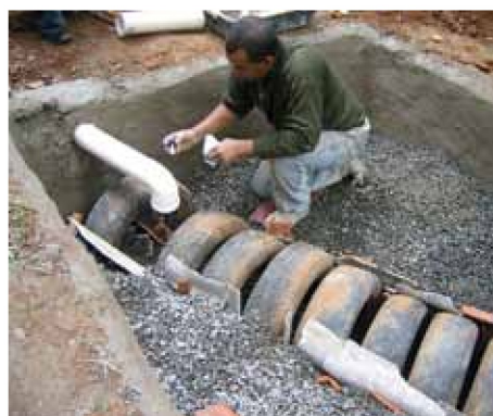
Foto 6 – Instalação do cano de entrada do esgoto
