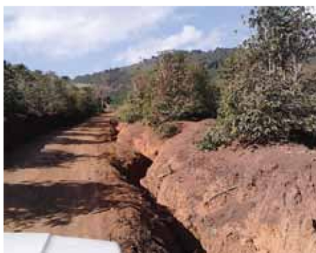
Estrada degradada por falta de planejamento e conservação
