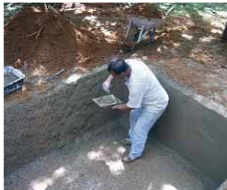
Foto 2 –Tela estrutural do ferrocimento e revestimento da tela com argamassa
