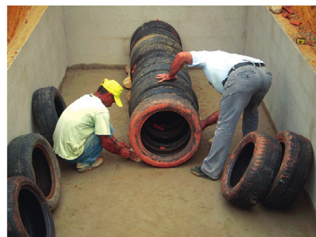
Imagem 7: Construção do duto de pneus da câmara anaeróbia
