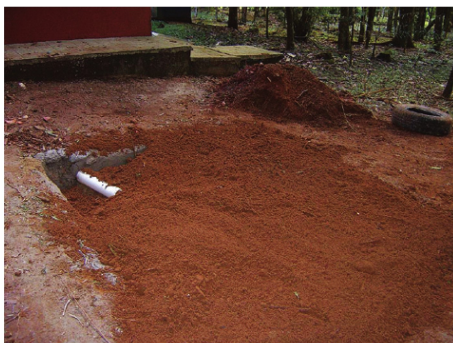
Imagem 13: Preenchimento com camada de solo
