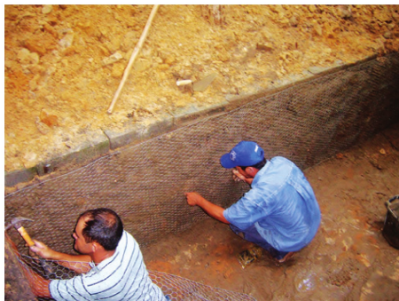
Imagem 5: Utilização da técnica de ferrocimento
