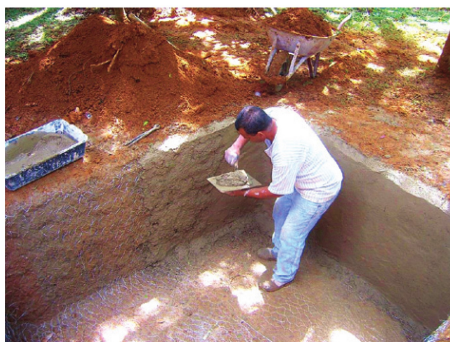
Imagem 6: Utilização da técnica de ferrocimento
