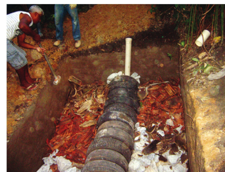
Imagem 9: Preenchimento da câmara anaeróbia com camada de entulhos
