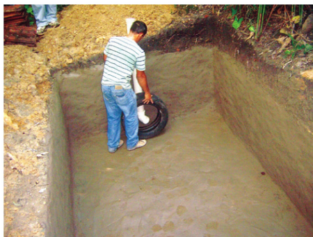
Imagem 3: Tubo de entrada do esgoto
