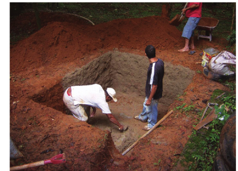
Imagem 2: Impermeabilização das paredes e fundo do Tevap
