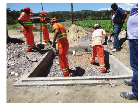
Imagem 11: Preenchimento com camada de brita
