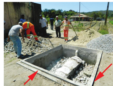
Imagem 16: Proteção contra o escoamento superficial
