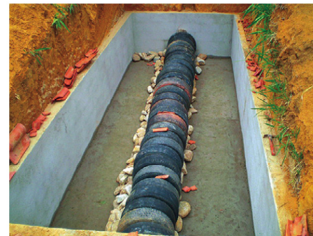
Imagem 8: Duto de pneus da câmara anaeróbia
