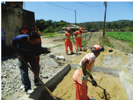
Imagem 12: Preenchimento com a camada de areia
